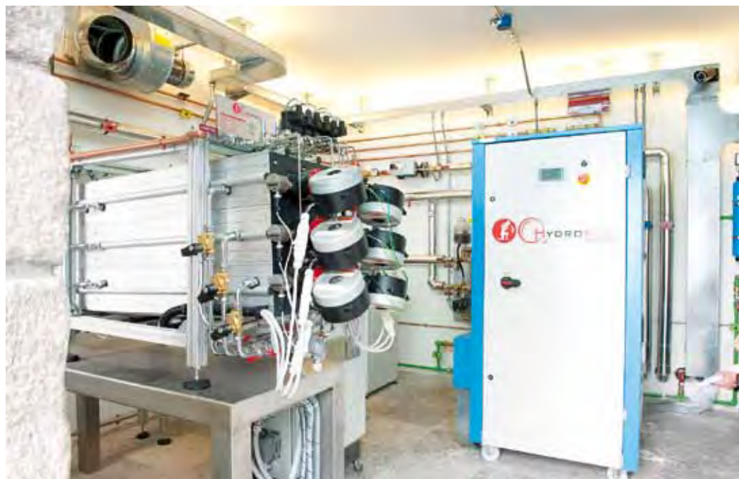
La centrale ad idrogeno dell'hotel San Rocco
