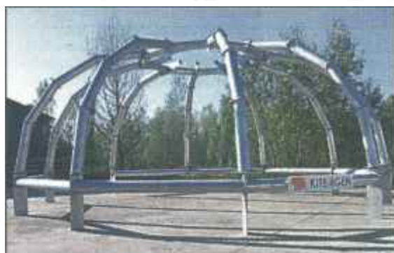
La struttura della cupola in fase di montaggio a Chieri
